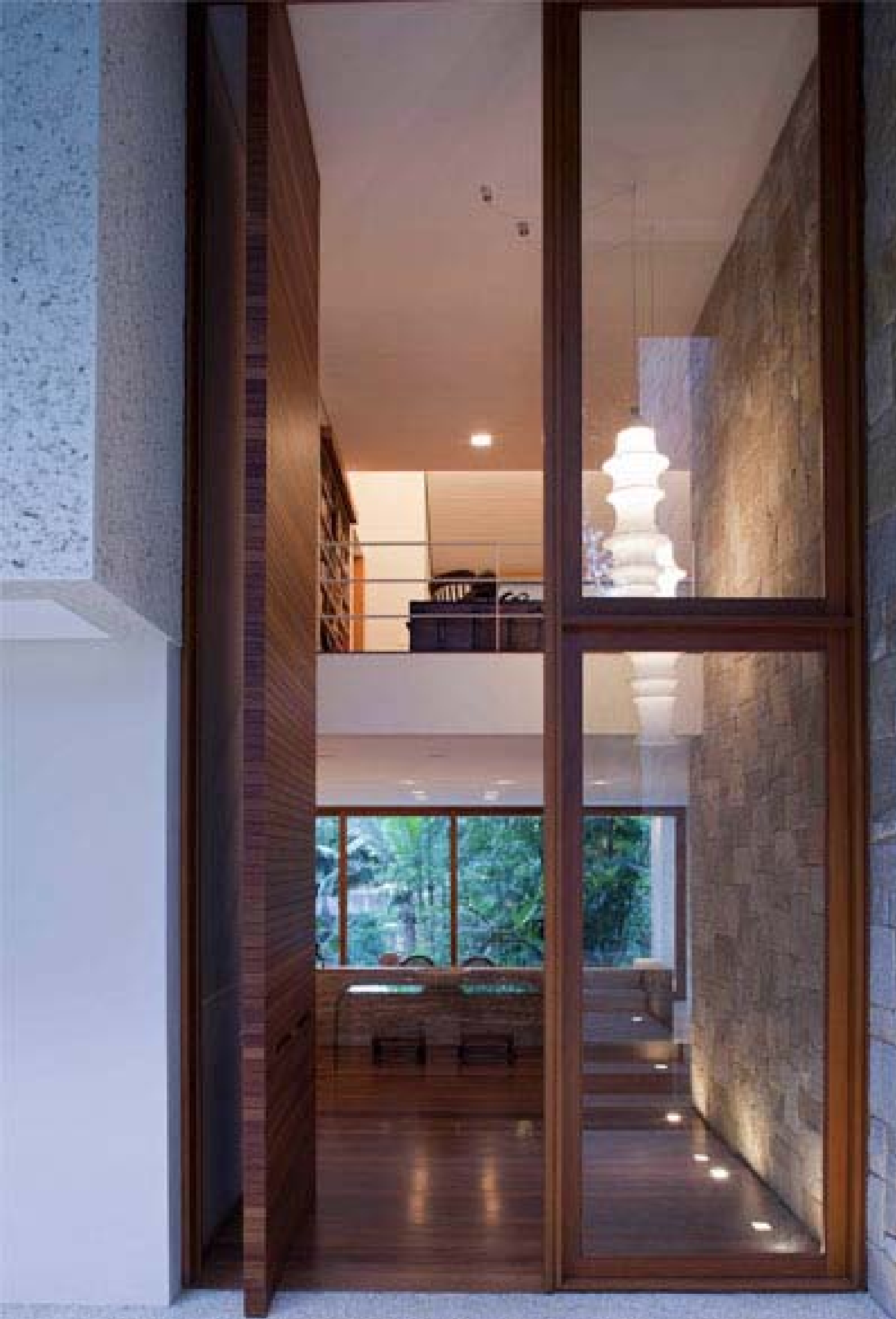
Porta de entrada pivotante em réguas de cumarú com 5,20m de altura
