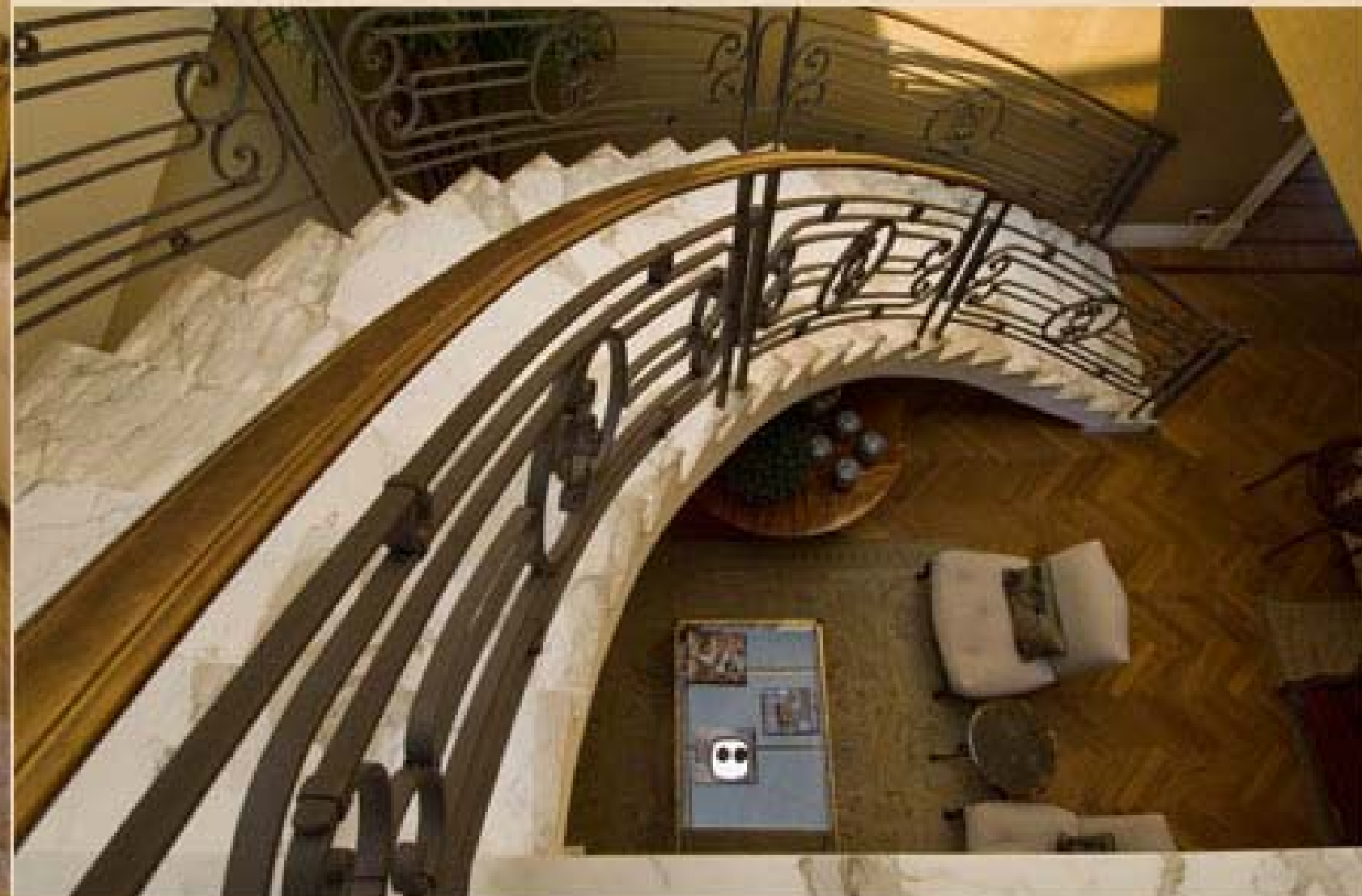
Detalhe da escada principal construída no apartamento. Toda revestida em mármore calacata oro e corrimão em ferro com bronze.
