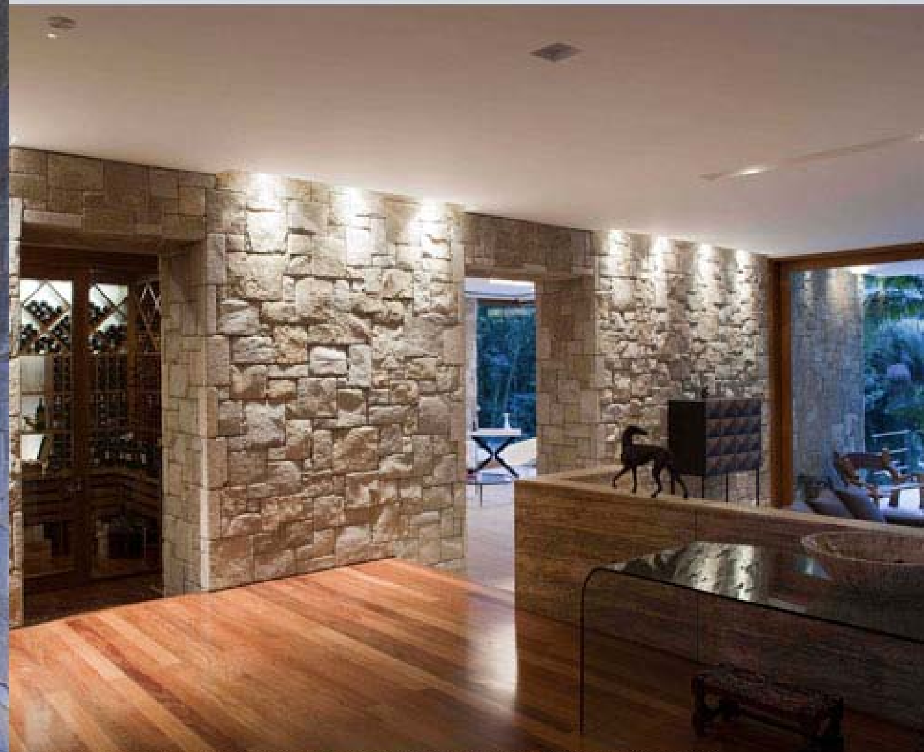
Parede de pedra moledo corte reto que atravessa a casa inteira dentro e fora
